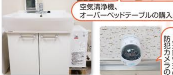
ハンドソープディスペンサー、温水器の設置。
